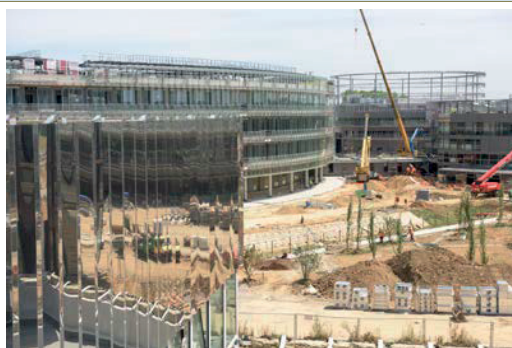
Le chantier d'EDF
